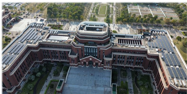
图书馆楼顶的分布式光伏发电设备
