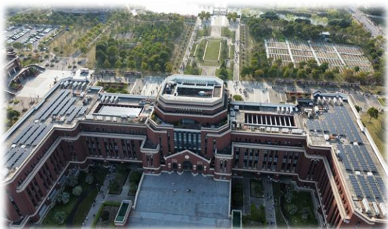
图书馆楼顶的分布式光伏发电设备
